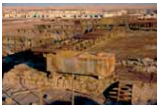
Estado actual de la zona de muelles de secado y de bateas de cristalización del salitre.
