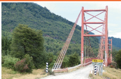
Puente colgante sobre río Rosselot
