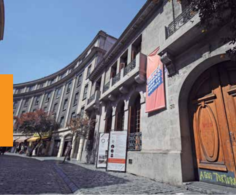
Fachada de Londres 38 Facade of Londres 38
