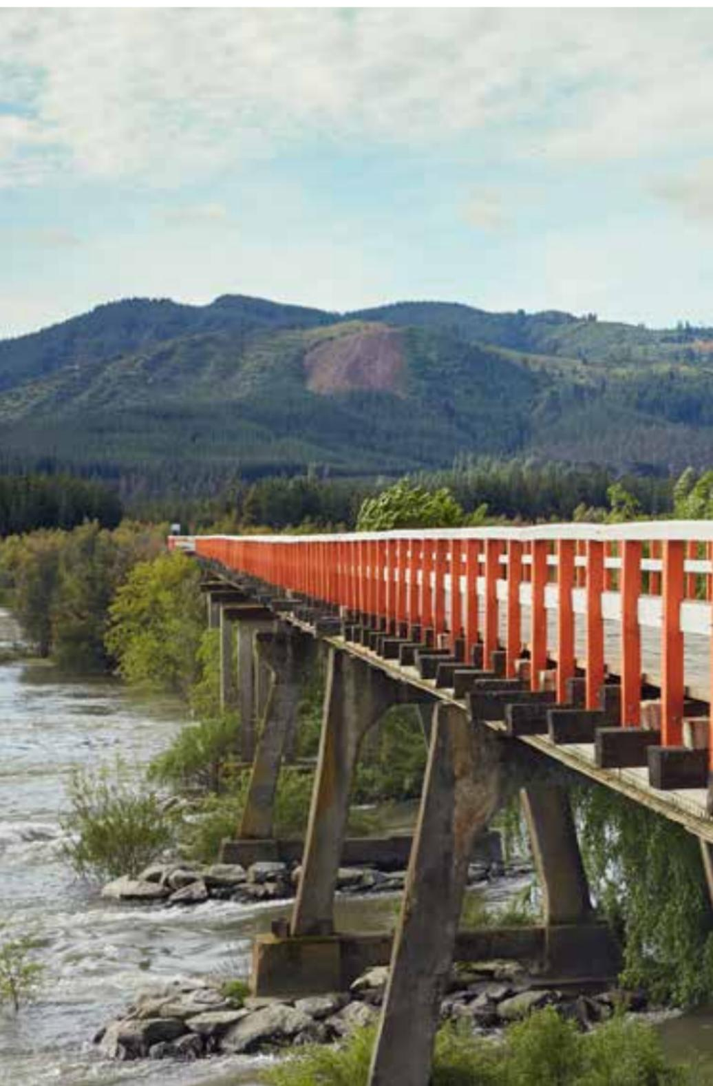
tipos diferentes, en la cual las más antiguas son estructuras tipo marco con 2 pilares inclinados y viga cabezal.
